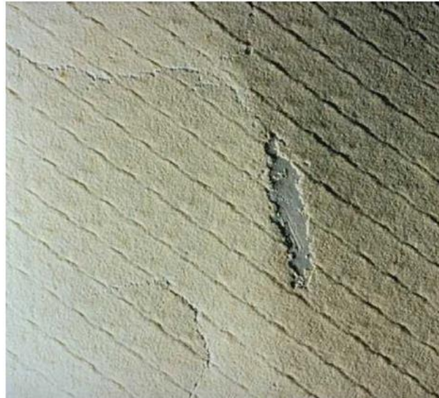
FIGURA 5 - DEPOSIÇÃO DE SAIS EM UMA MEMBRANA
